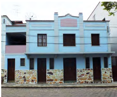
Imagem da fachada do Edifício São José reformada no final de 2018.
