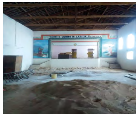
Imagem interna do prédio no início da reforma em 2016.
