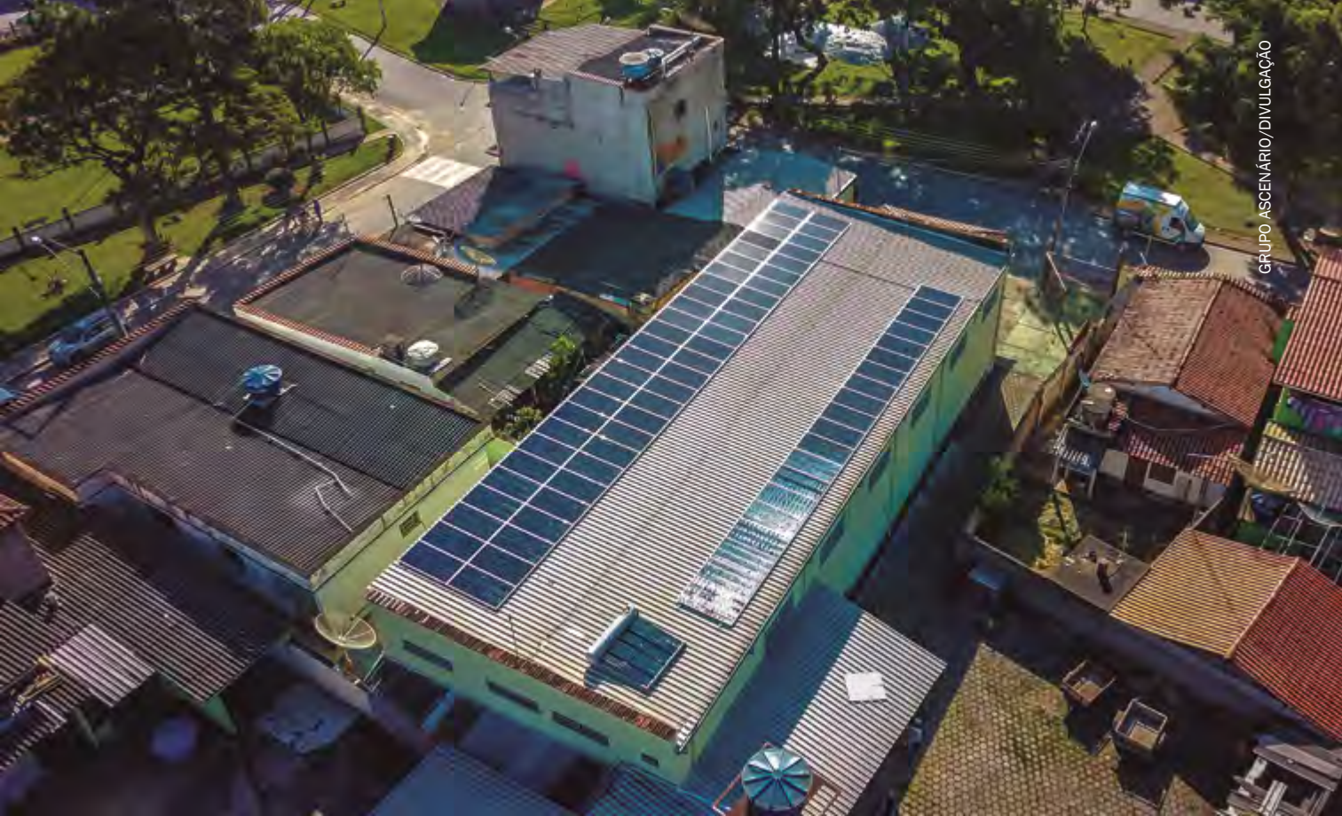
Projetos do Grupo Ascenário na região. Placas captam luz solar em processo de conversão para energia econômica e sustentável
