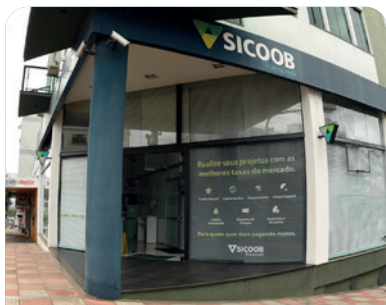
Rua Aratiba, 400, Centro. (54) 3522 0180
